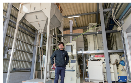
乾燥機には携帯端末から状況をチェックできるICTを取り入れる
